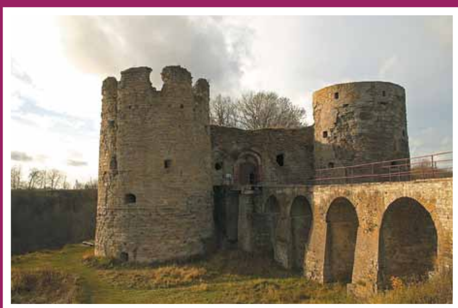
Древняя крепость в Копорье. Ленинградская область
