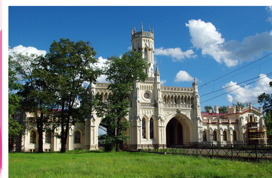
Здание вокзала Новый Петергоф
