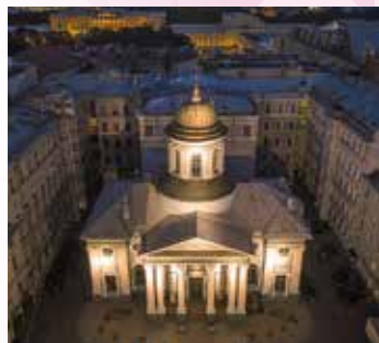
Армянская церковь Святой Екатерины в Санкт-Петербурге
